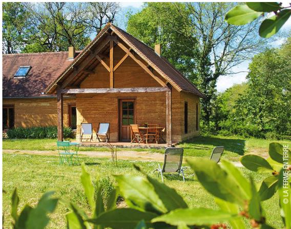
Le pisé intéresse pour son esthétique. Mais utilisé à l'extérieur, il doit être protégé des ruissellements d'eau.
